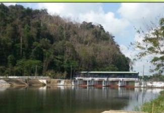
D. โครงการประตูระบายน้ำคลองประเทสียน
