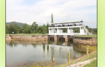
F. โครงการประตูระบายน้ำคลองกะลาส
